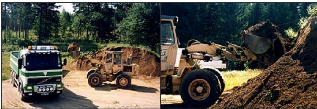
Utlastning av väggrus.
